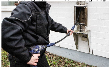
Afb. 21: Gebruik van de duwstang met handvat (Artikel 11270)
