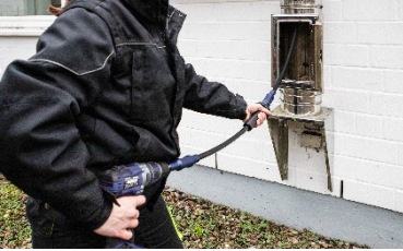
Fig. 20: Utilizzo dell'asta di spinta con impugnatura (Art. 11270)
