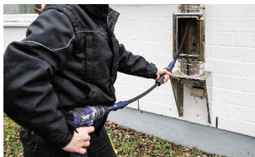
Abb. 3: Nutzung der Schubstange mit Griffstück (Artikel 11270)
