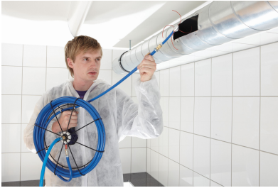
Abb. 5: Anwendungsbeispiel: Reinigung einer Rohrleitung
