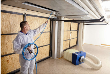
Abb. 16: Reinigung der Leitung mit Führungsrollkugel und Luftpeitsche, Absaugen mit der Staubfalle
