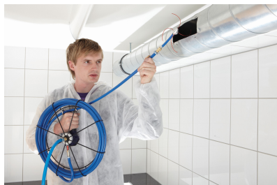
Imm. 39: Esempio: pulizia di un canale rotondo
