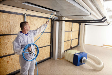
Imm. 50: Pulizia del canale con la sfera, la frusta e il filtro aspiratore.
