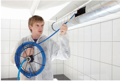
Fig. 56: Exemple d'application : Nettoyage d'un conduit
